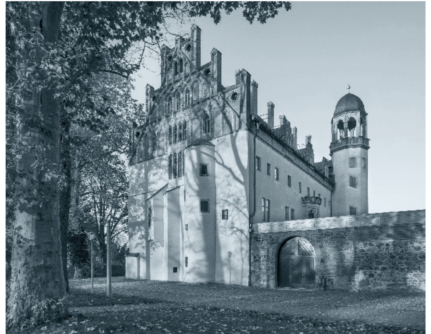
Energetische Ertüchtigung auch im Außenbereich
