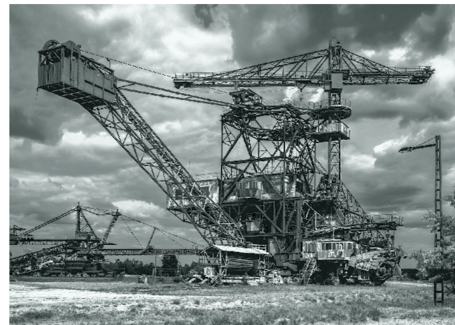
Am Gerät wurden die Schwellen gewechselt und ein Fahrstuhl installiert.
